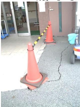
地面の沈下によるひび割れ
