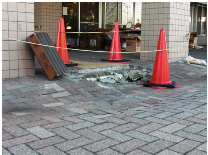
余震が起きる前の玄関付近の陥没。この状態からさらに深く・大きくなってしまったとの報告がありました。
